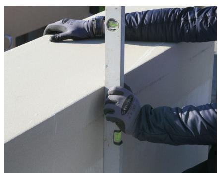
4. Austrotherm Atikové prvky sa môžu lepiť len na stabilný podklad zbavený prachu a mastnoty. Lepidlo sa nanesie na prvak a podklad v mieste lepených plôch. Dodržte návod na spracovanie lepidla.
