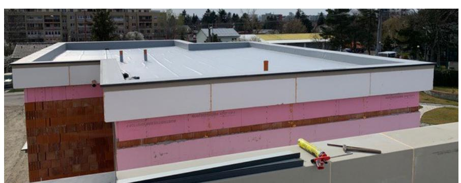
6. Mechanické upevnenie sa vykonáva pomocou PVC uholníka do existujúceho podkladu.
